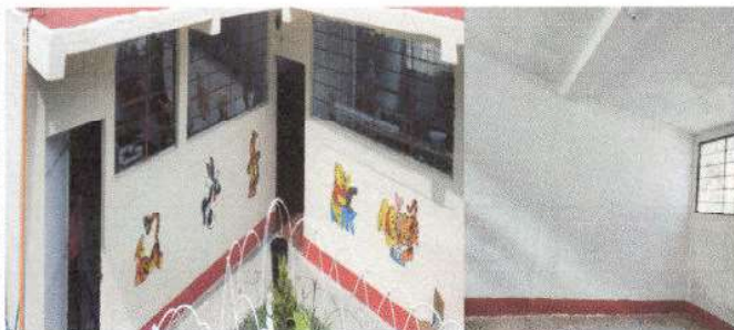
Foto7: Pintura en muros exteriores e interiores
