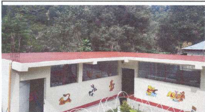
Foto1: Mejoramiento de losa con pañuelos de tipo impermeabilizante
