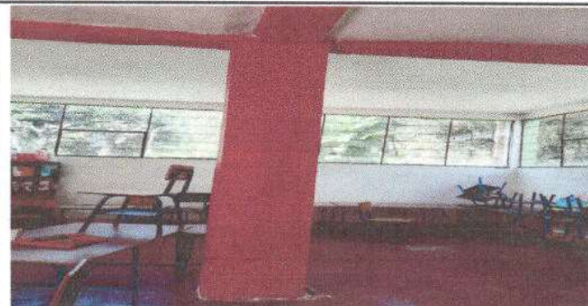
Foto 6: Mejoramiento de losa con reforzamiento de columna interna.
