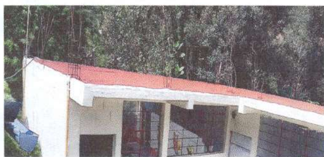
Foto 3: Impermeabilización de losa, raspado exterior
