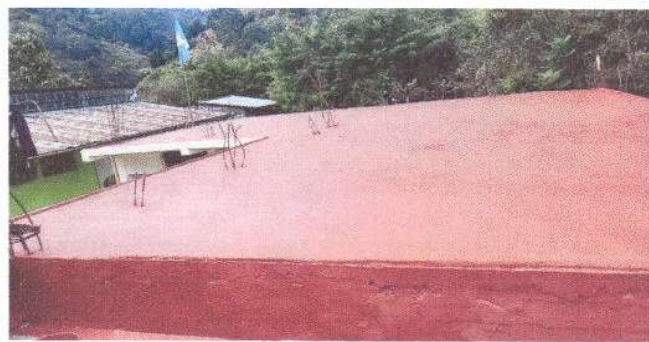
Foto 4: Impermeabilización de losa, electromalla de 1/4 y aplicación de impermeabilizante
